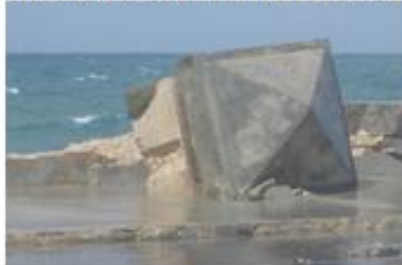
Fallo estructural del muro actual durante el huracán Wilma (octubre 2005)
