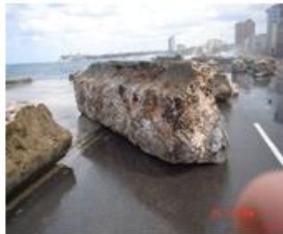
Fallo estructural del muro actual durante el huracán Wilma (octubre 2005)
